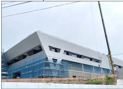
① 庁舎棟 北東側外観
