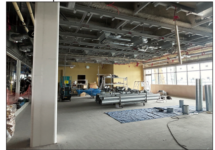
③ 庁舎棟 内装施工状況その2
