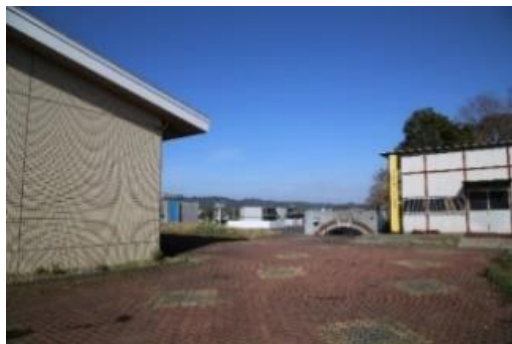
現状写真(撮影箇所①)
