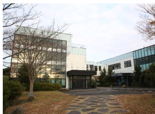
実習棟外観写真（撮影箇所①）
