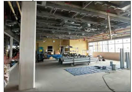
③ 庁舎棟 内装施工状況その2
