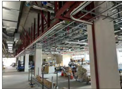
② 庁舎棟 内装施工状況その1
