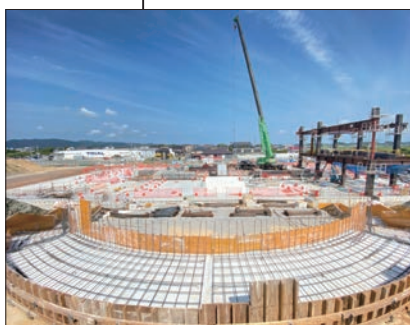
① 庁舎棟 鉄骨建方開始
