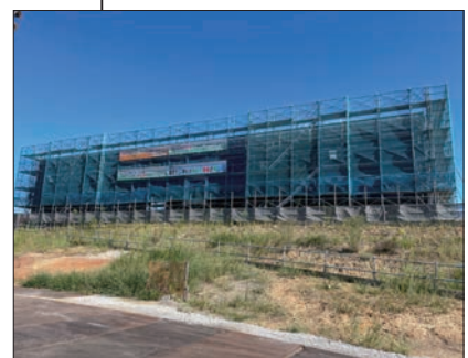
③ 博物館別館 屋根・外装施工
