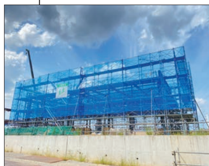
② 車庫棟 鉄骨建方完了
