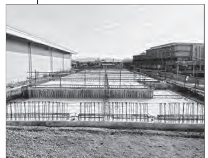
③ 博物館別館 基礎躯体
