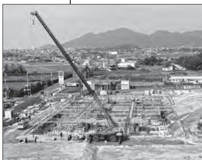
① 庁舎棟 基礎躯体
