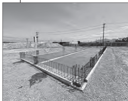
② 車庫棟 基礎躯体
