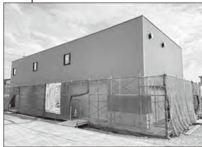
② 車庫棟 外装工事完了
