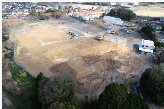
② 剣南小学校の解体工事を終え、鞍手小学校の敷地整備作業も完了しました。
