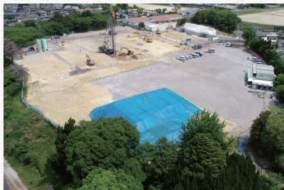
③ 柱状地盤改良工事や掘削作業、基礎躯体工事を進めています。工事全体の約10%が完了しました。
