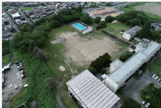
① 解体前の剣南小学校。写真奥にプール、右側に校舎、手前に体育館が配置されていました。
