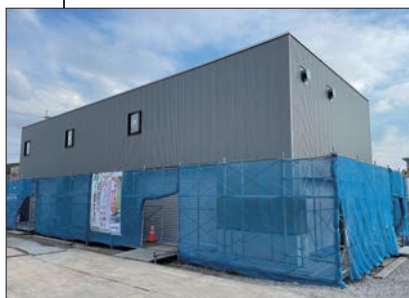
② 車庫棟 外装工事了
