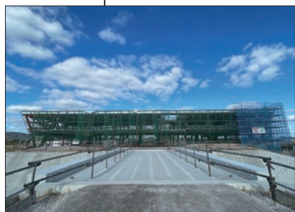
① 庁舎棟 鉄骨建方完了
