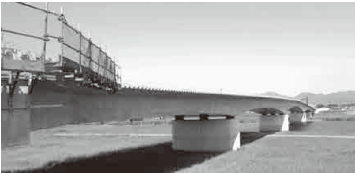
▶現在の（仮称）遠賀川渡河橋
