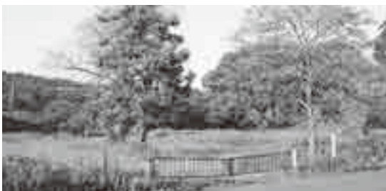
▶泉水改良住宅造成工事用地 (新延字野田)
