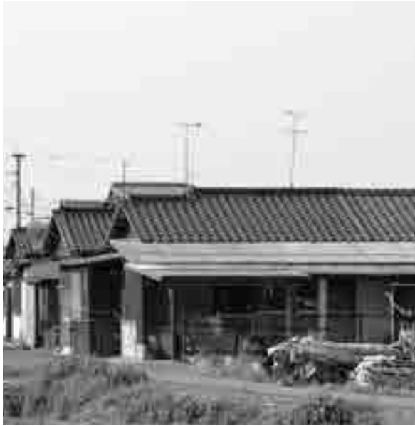
高ノ口町営住宅
