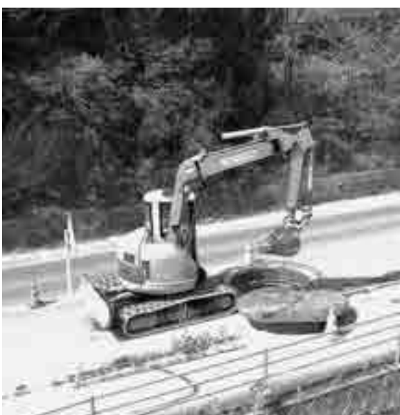
下水道工事の様子
