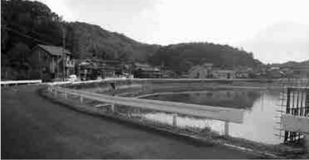
農業施設の整備に係る事業で安全フェンスの設置が予定される、新北の大日池
