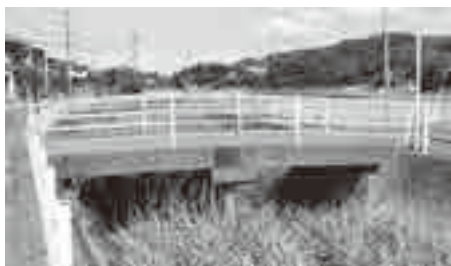
平成 25 年度に改修予定のたぶ木橋
