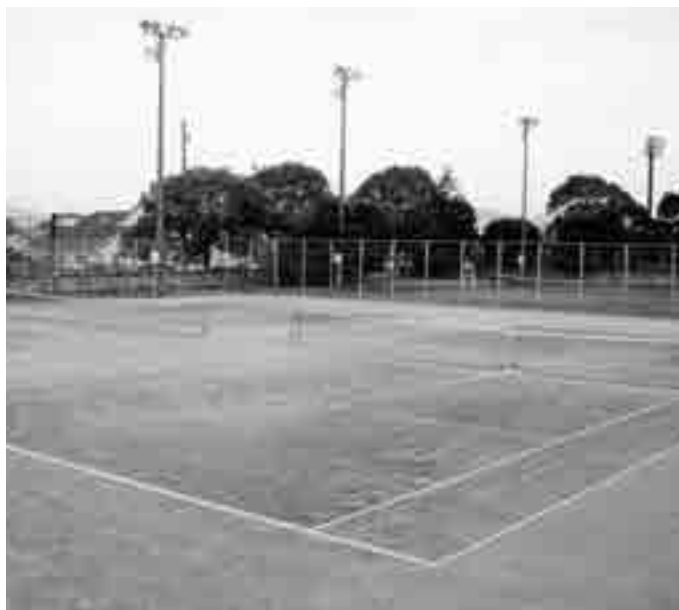
改修工事が完了したテニスコート (きめ細かな交付金を活用)
