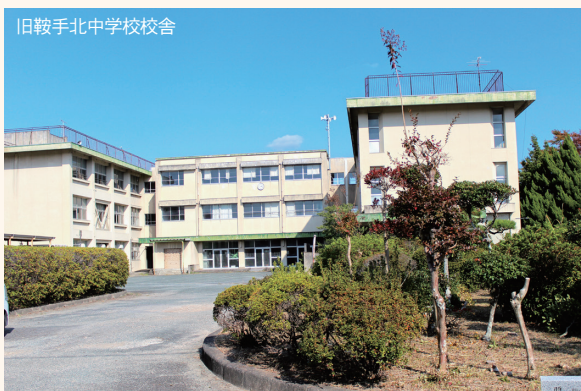
旧鞍手北中学校校舎
