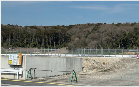
造成中のデータセンター建設予定地 (鞍手インター周辺)
