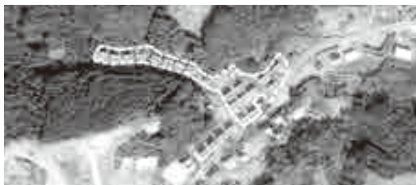
▲坑廃水改善対策工事のため処分された住宅用地
