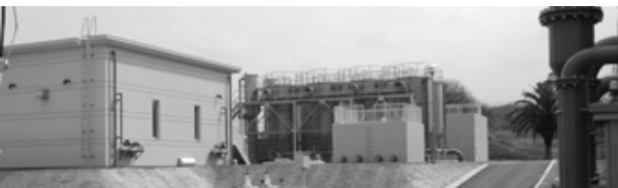
改良工事が完了した浄水場
