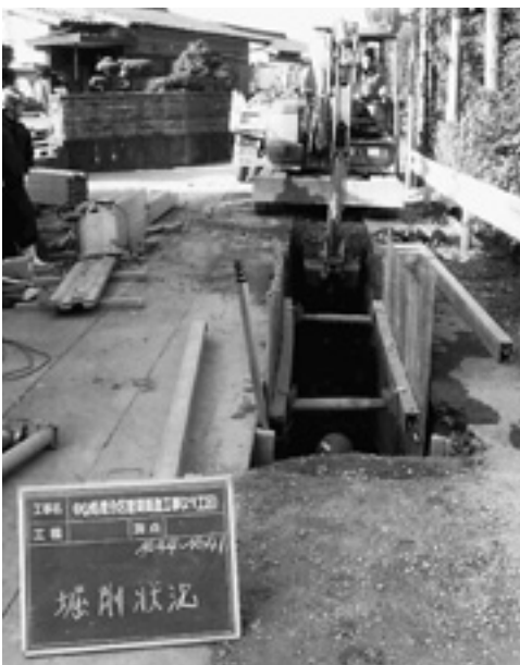
下水道工事の様子
