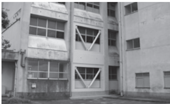
豊翔館（旧鞍手分校）の耐震補強工事の様子
