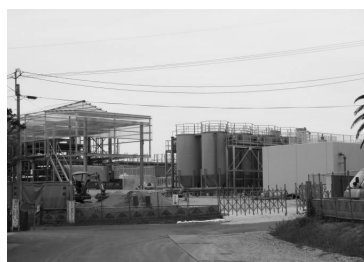
建設中の浄水施設
