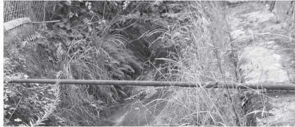
泉水団地改良住宅横から湧き出す赤水
