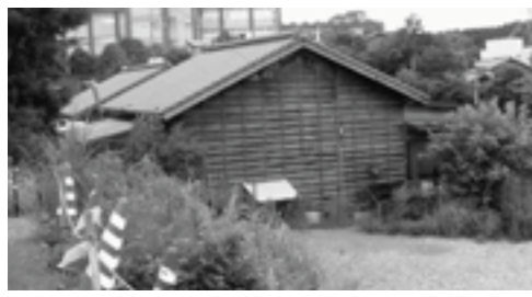
町営住宅の状況
