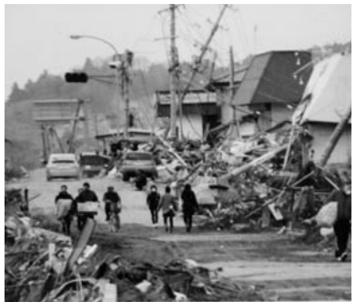
被災した宮城県東松島市の様子（町職員撮影）
