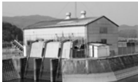
新北排水機場
