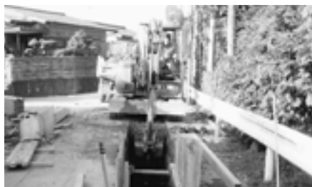
下水道の工事状況
