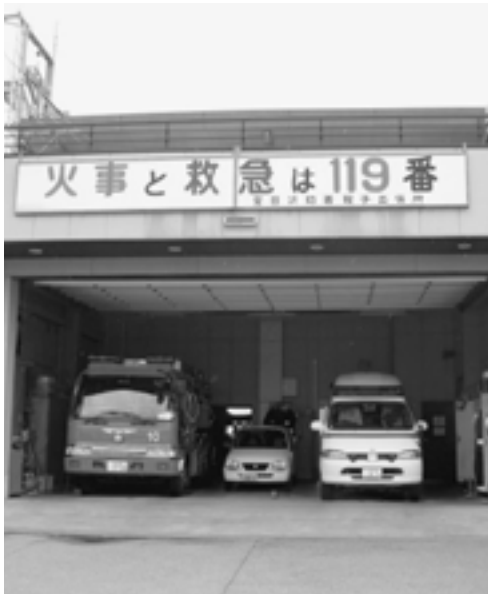
宮田消防署鞍手出張所
