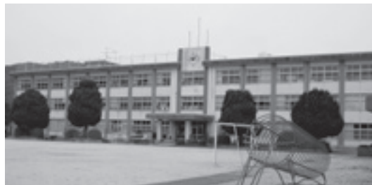
耐震補強工事が行われる新延小学校
