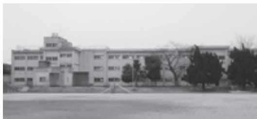
耐震補強工事が行われる剣南小学校
