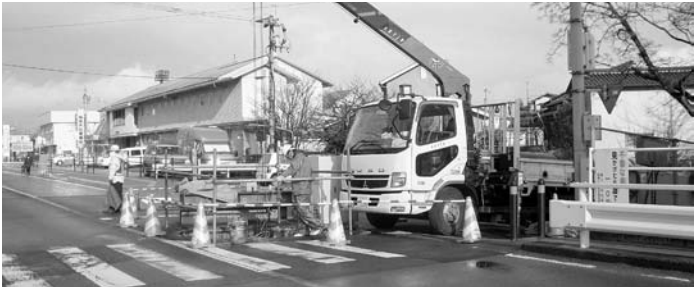
管渠築造工事が進む中山処理分区(第33工区)
