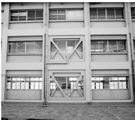
耐震補強工事が完了した北中学校の校舎
