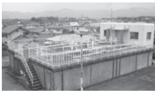
改修工事の入札が延期となった中央浄水場
