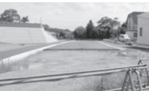
建設工事中的の新設県道
