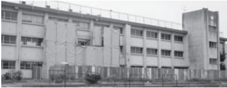
耐震補強工事中の鞍手北中学校
