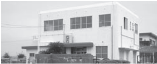
改良工事の入札が延期された中央浄水場
