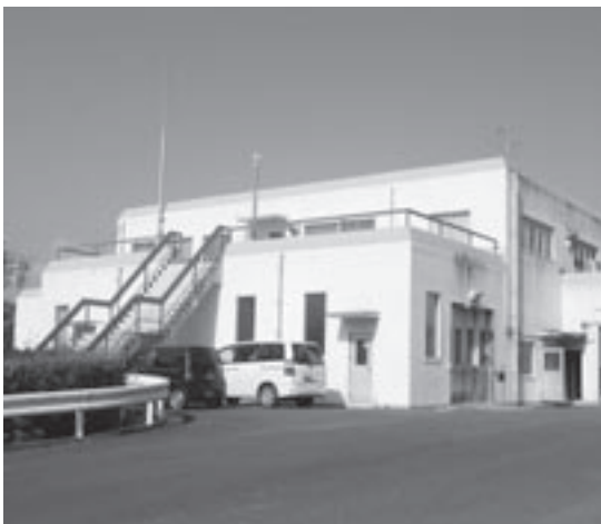
修繕工事が行われる衛生センター
