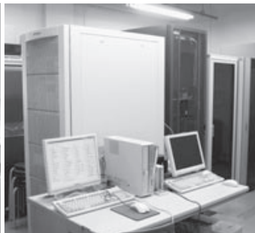
移設工事が行われる電算室
