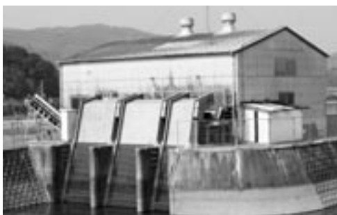
新北排水機場
