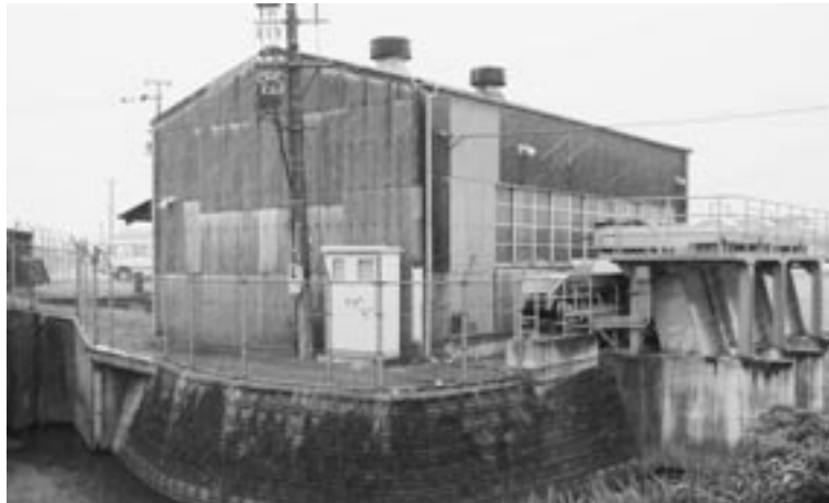
新川排水機場
