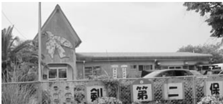
建替工事が行われる剣第2保育所
