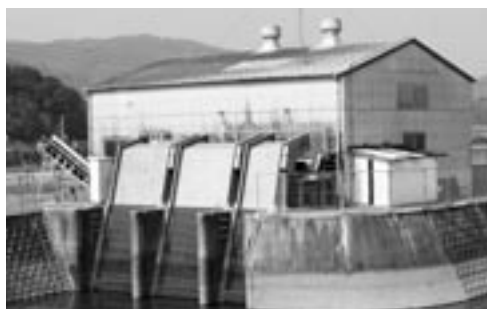
新北排水機場
