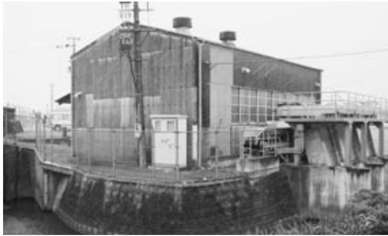
新川排水機場
