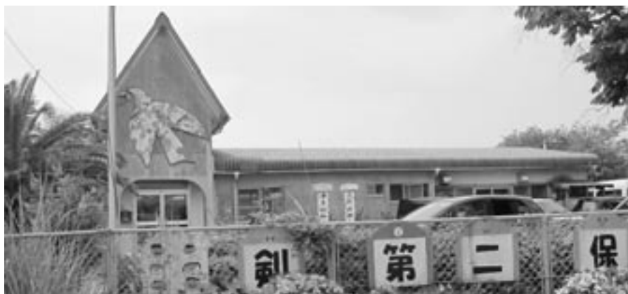
建替工事が行われる剣第2保育所
