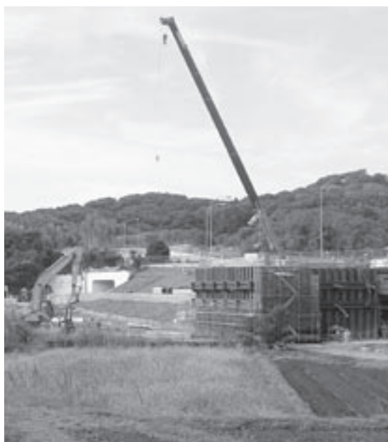
建設が進むインターチェンジ建設工事
