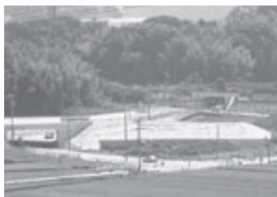
工事が進む（仮称）筑豊インターチェンジ
