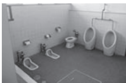
改修工事が行われる保育所のトイレ
