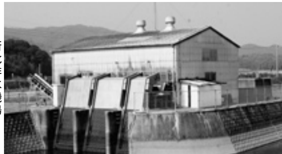
新北排水機場
