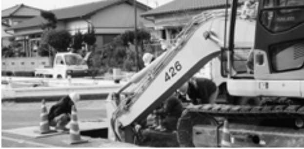
下水道工事の状況
