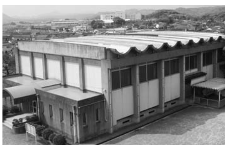
交付金事業で防水工事が行われる古月小の体育館
