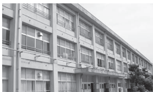
耐震診断が予定されている剣南小学校
