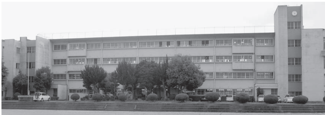
耐震診断は、鞍手南中学校（写真）のほか、剣南小学校、剣北小学校、古月小学校、新延小学校、鞍手分校が予定されています
