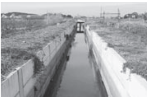
平成19年度で工事が終了した境川 (木月付近 左が鞍手町)
