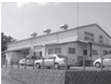
設備等が老朽化している給食センター
