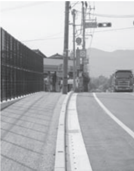
県道の歩道工事に町有地を売却 (新延小学校横)
