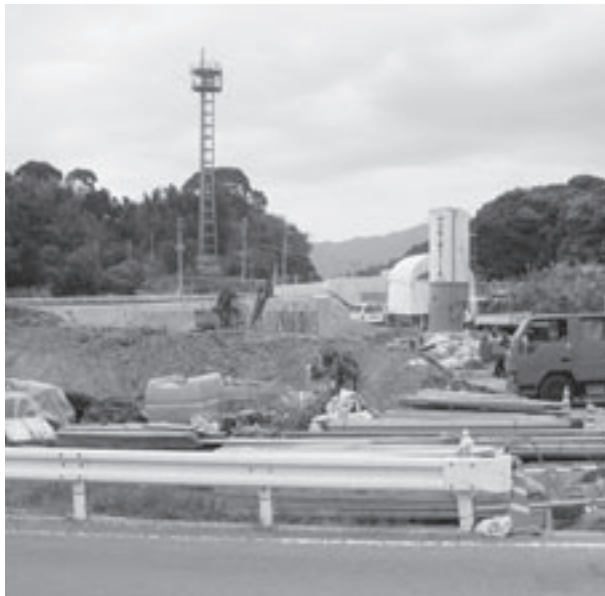
(仮称) 筑豊インター建設工事現場
