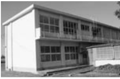
改修の陳情が出ている特別教室棟
