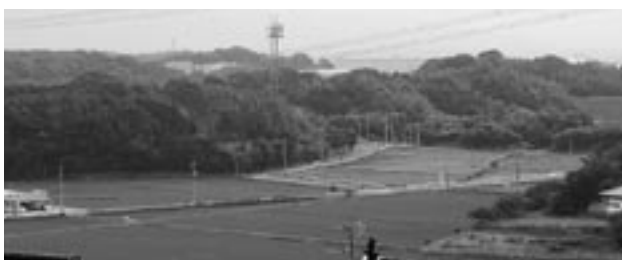
(仮称) 筑豊インター建設予定地
