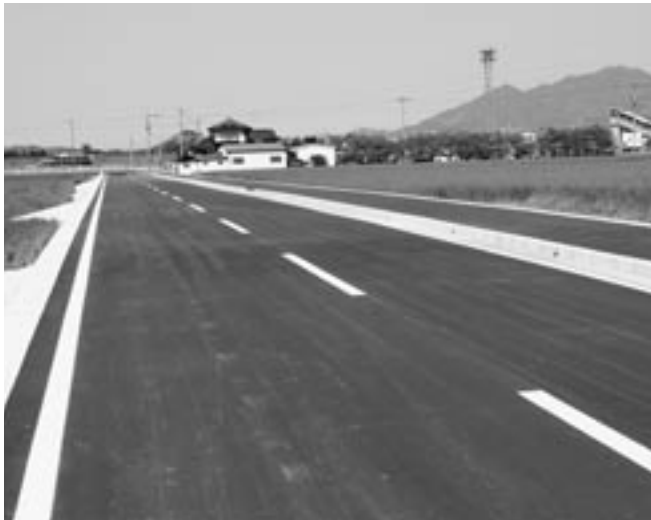
特定地域開発就労事業で整備された鞍手駅前の道路
