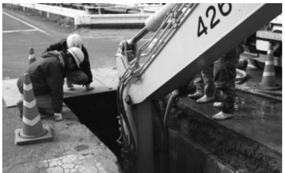
下水道工事現場
