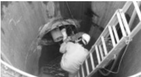
変更契約のあった工事現場
