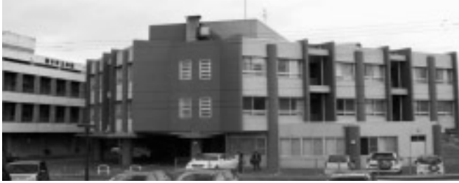
老健施設「鞍寿の里」
