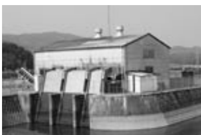
新北排水機場
