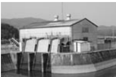
新北排水機場
