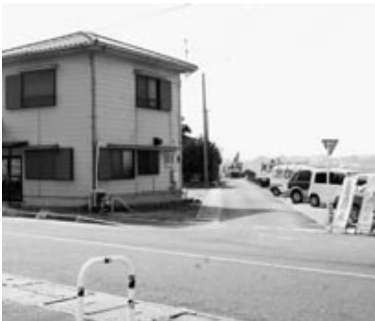
鞍手駅前の工事箇所
