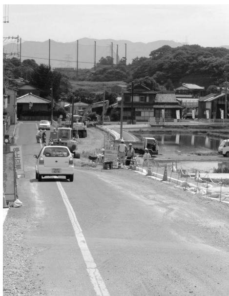
公共工事現場
