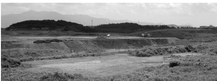
企業誘致のための造成地（宮若市）
