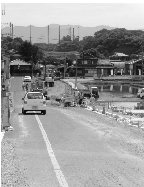
公共工事現場
